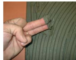
Vérifier que le ciment est frais.
