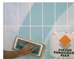
Jointer 24 heures après la pose.
