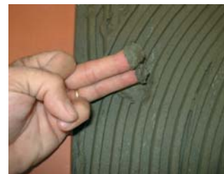
Comprovar que el ciment estigui fresc.
