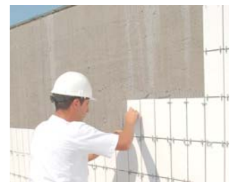
Pegado encima del HIDROELASTIC
