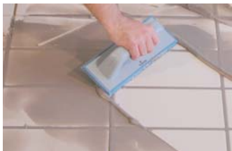
Rejuntar pasadas 4 horas de la colocación.
