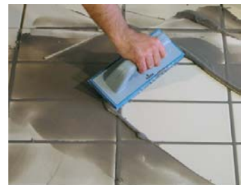
Jointoiement entre 4 et 12 heures après la pose.
