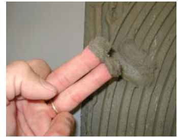
Vérifier que le ciment est bien frais.
