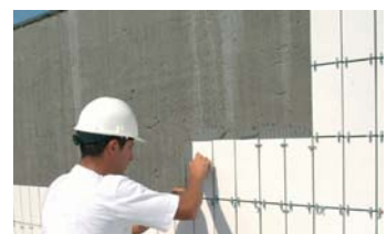
Incollaggio sull'impermeabilizzazione.
