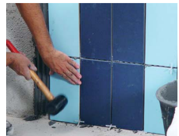
Utilizzare una mazzetta di gomma.
