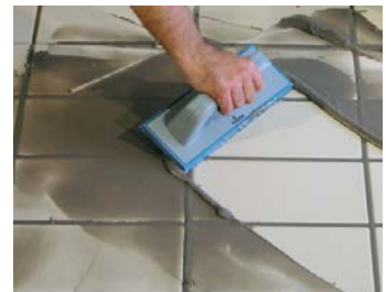
Rejuntar passadas 4-12 horas após a colocação.
