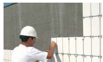
Colagem sobre a impermeabilização
