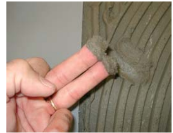
Comprobar que el cemento esté fresco.
