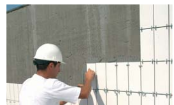
Pegado encima de la impermeabilización
