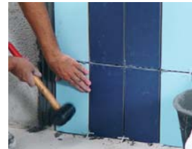
Utiliser un maillet en caoutchouc.
