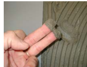
Vérifier que le ciment est frais.
