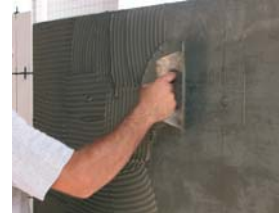
Utiliser la technique du double encollage.
