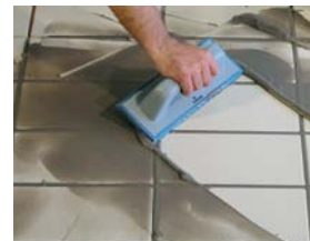
Jointer 4 heures après la pose.
