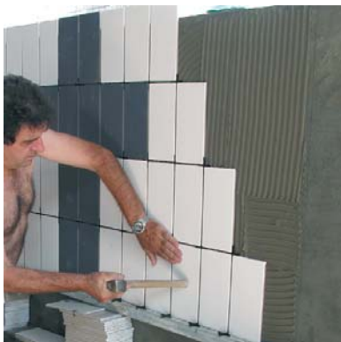
TECNOCOL FLEX es ideal para pegar gres sobre la impermeabilización de HIDROELASTIC en piscinas.
