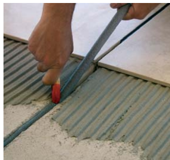
Sur de grands orifices, mettre d'abord SELLALASTIC FOAM
