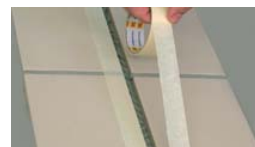
Mettre d'un côté et de l'autre du ruban adhésif spécial peinture.
