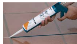
Pour l'appliquer, utiliser un pistolet universel.
