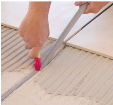
Encabir el SELLALASTIC FOAM en la junta de dilatació amb una fusteta.
