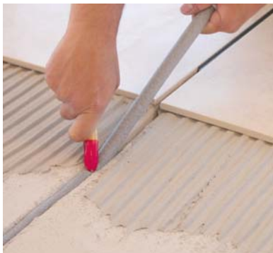
Embutir el SELLALASTIC FOAM en la junta de dilatación con una maderita.
