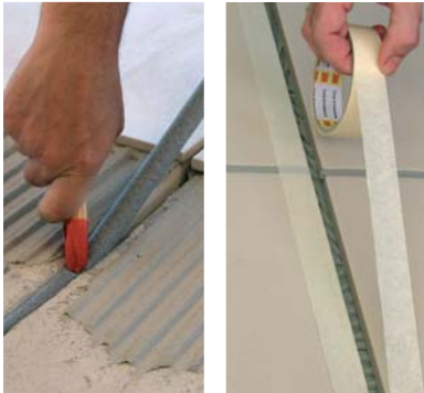
Inserire prima SELLALASTIC FOAM ; proteggere i bordi del giunto di dilatazione con nastro adesivo da pittore.
