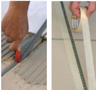
Encabir prèviament SELLALASTIC FOAM ; protegir els costats de la junta de dilatació amb cinta de pintor.
