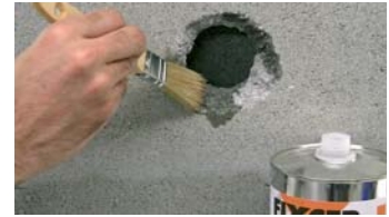
Soak the concrete with IMPRIMACIÓN primer.
