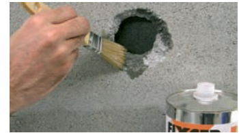
Soak the concrete with IMPRIMACIÓN primer.
