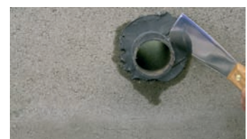
Régulariser toute la surface.
