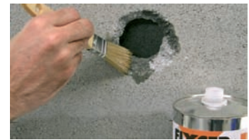
Imbiber le béton d'ENDUIT.
