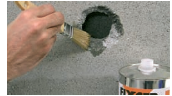
Embeber o betão com ISOLANTE.
