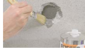
Empapar de IMPRIMACIÓN el hormigón.
