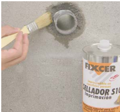
Sur des supports ABSORBANTS appliquer au préalable une couche d' IMPRIMACION SELLADOR S10 .
