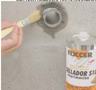
Em suportes ABSORVENTES, aplicar primeiro o ISOLANTE SELLADOR S10 .
