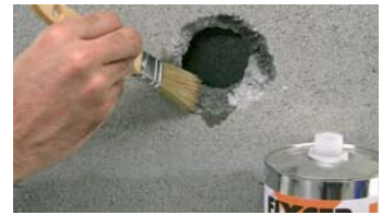
Imbiber le béton d'ENDUIT.
