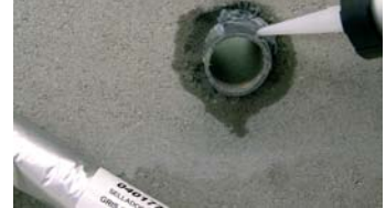
Veiller à ce qu'il pénètre bien en profondeur.
