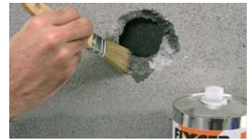
Empapar de IMPRIMACIÓN el hormigón.
