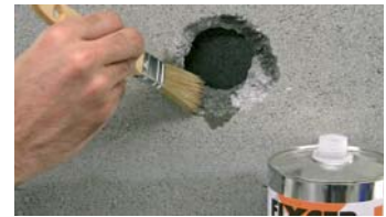
Saturar de IMPRIMACIÓN el formigó.
