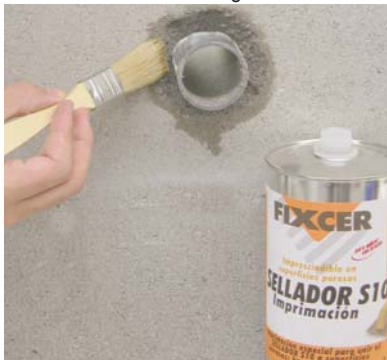
En suports ABSORBENTS, aplicar primer la IMPRIMACION SELLADOR S10 .
