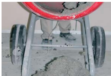
Mortero con aspecto de "arena mojada"
