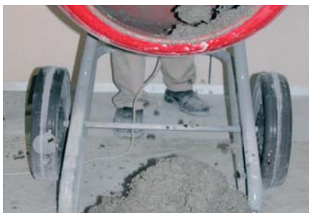
Morter amb aspecte de "sorra mullada"
