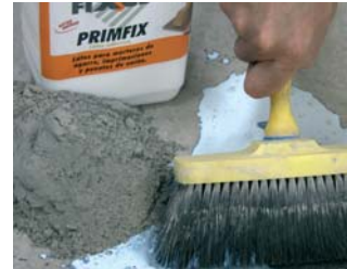
Verter directamente sobre a calda.
