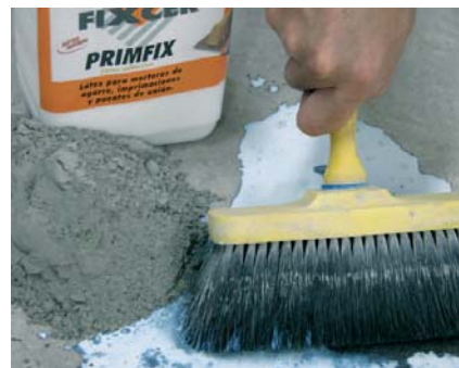
Calda de aderência: PRIMFIX + Portland puro.
