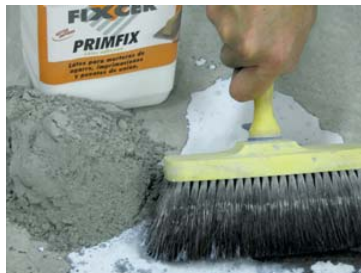
Imprimación previa con PRIMFIX + Pórtland (1:1)
