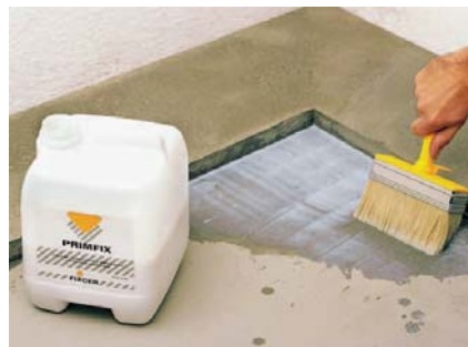
Amb PRIMFIX imprimem superfícies absorbents.
