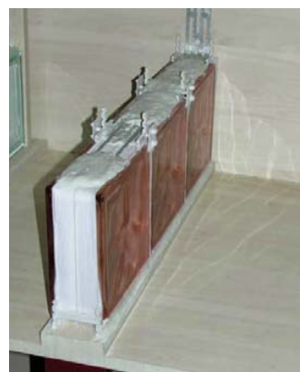
Usar crucetas de plástico y varillas galvanizadas.
