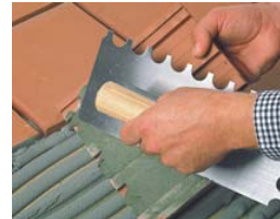
Usar la técnica del doble encolado.
