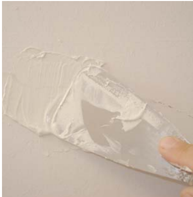
Spatolare e riempire tutte le fessure e tutti i fori.
