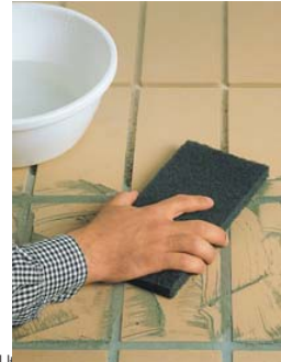
Utiliser le FIX-BUCKET et la taloche de nettoyage.
