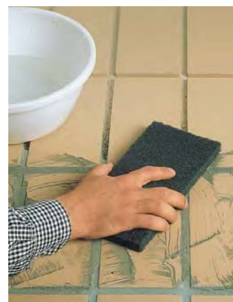
Usar el FIX-BUCKET y la llanas de limpiar.
