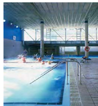
Rejuntado impermeable en piscinas.
