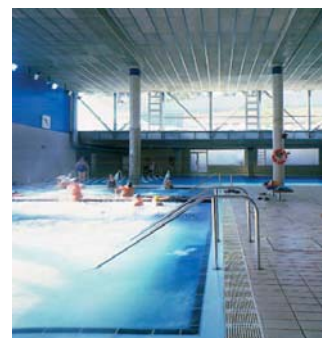
Rejuntat impermeable en piscines.
