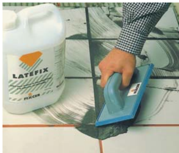
Rejuntat de juntes velles
