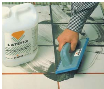
Rejuntado de juntas viejas.
