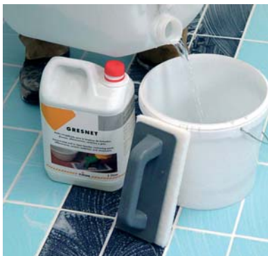
Le dernier nettoyage se fait 7 jours après avec GRESNET dilué dans 10 parts d'eau.
