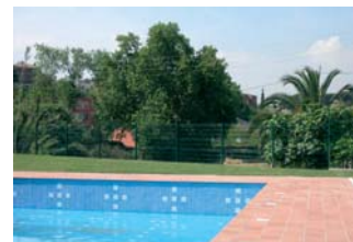
Rejuntat impermeable en piscines.
