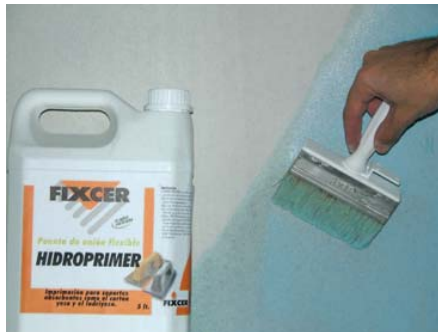
Imprimació amb HIDROPRIMER .
