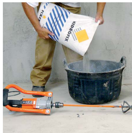
Impastare HIDROFIX con acqua servendosi di un miscelatore.
