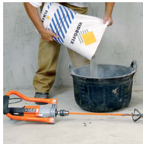
Mesclar el HIDROFIX amb aigua usant un trepant.
