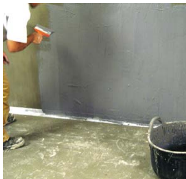
Aplicación de la 1ª mano de HIDROFIX .
