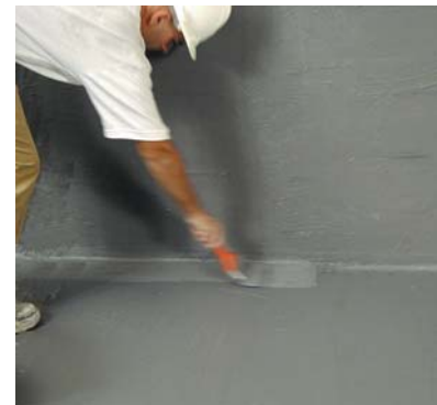
Aplicación de la 2ª mano de HIDROFIX .
