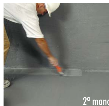
Stesura della seconda mano di HIDROELASTIC .
