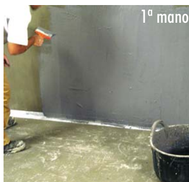
Stesura della prima mano di HIDROELASTIC .
