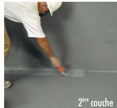
Application de la 2 ème couche de HIDROELASTIC .
