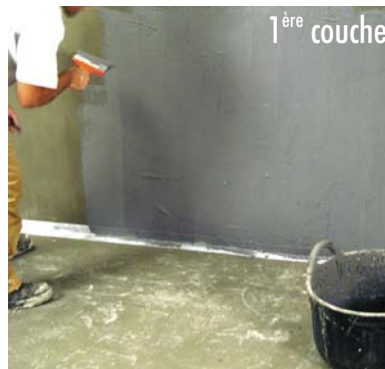
Application de la 1 ère couche de HIDROELASTIC .
