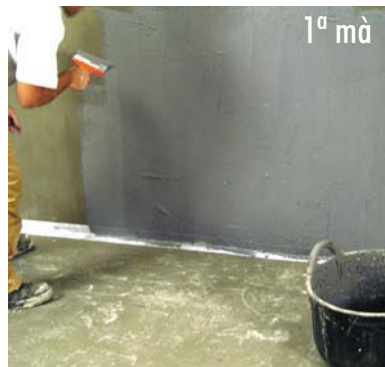
Aplicació de la 1ª mà de HIDROELASTIC .
