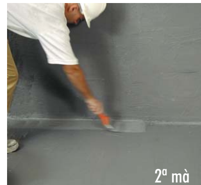
Aplicació de la 2ª mà de HIDROELASTIC .
