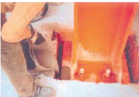
Pour product to fill all the space .
