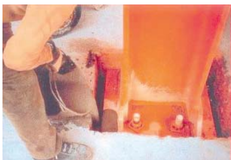
Verser en coulée en remplissant tous les trous.
