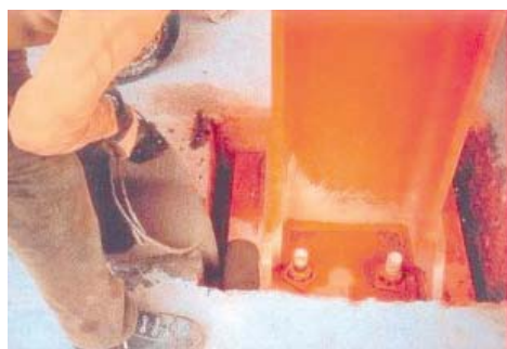
Verter por colagem enchendo todos os orifícios.
